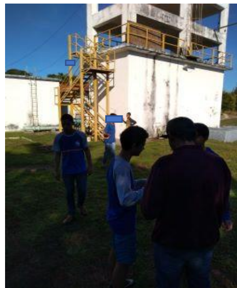
Figura 2 - Estação de captação e tratamento de água
