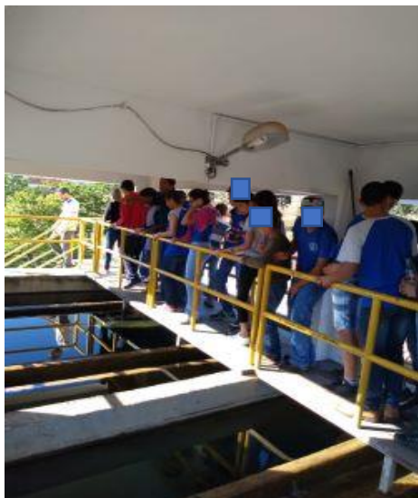
Figura 1 - Estação de captação e tratamento de água de Caiapônia-GO. Tanques de tratamento visualizado por cima
