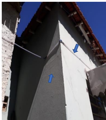
Figura 11 - Sistema de captação
